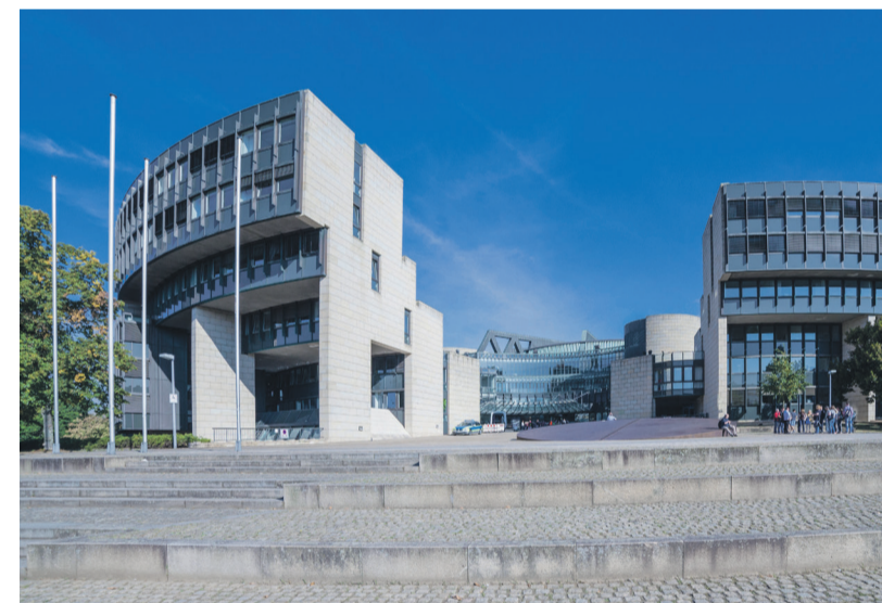
Markantes Gebäude am Rheinufer: Der nordrhein-westfälische Landtag ist ein Paradebeispiel für moderne, kreisrunde Architektur
